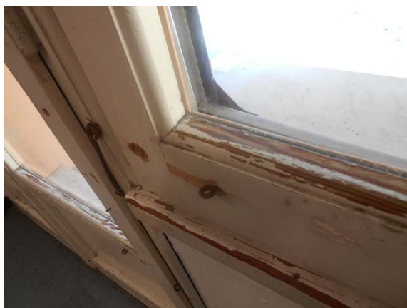
Figura 2.2 - Particolare dei serramenti – dettaglio angolo vetro
