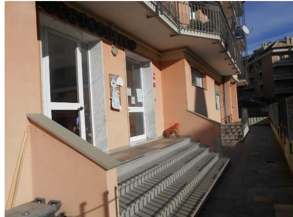
Figura 1.1 - Particolare della facciata principale
